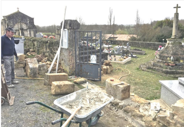
Réfection du pilier et une partie du mur du cimetière de Cazelles
