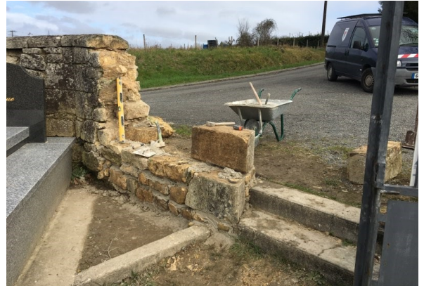
Réfection du pilier et une partie du mur du cimetière de Cazelles
