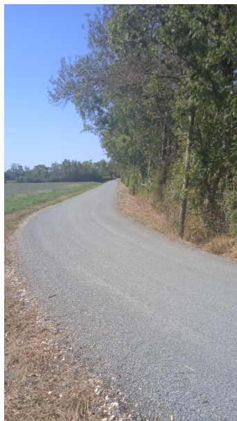
Réfection de la voirie au chemin de la Planiolle: route des marais, du Pont du Prêtre jusqu'au Port d'Espeau sur 2 km 400 avec rabotage de la route jusqu'à 10 cm et réinjection de goudron et gravillons.
