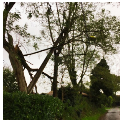
Intervention Enedis : poteau cassé avant tempête, chemin du Sablas
